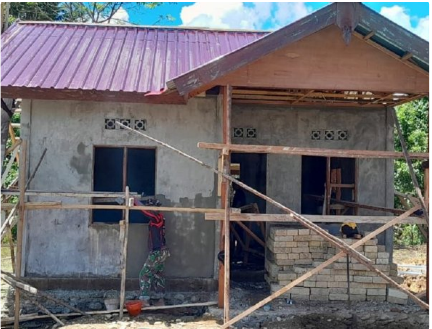
Terlihat bangunan Rumah Pastori Tipe 36 Yang Sudah Rampung 78 Persen
